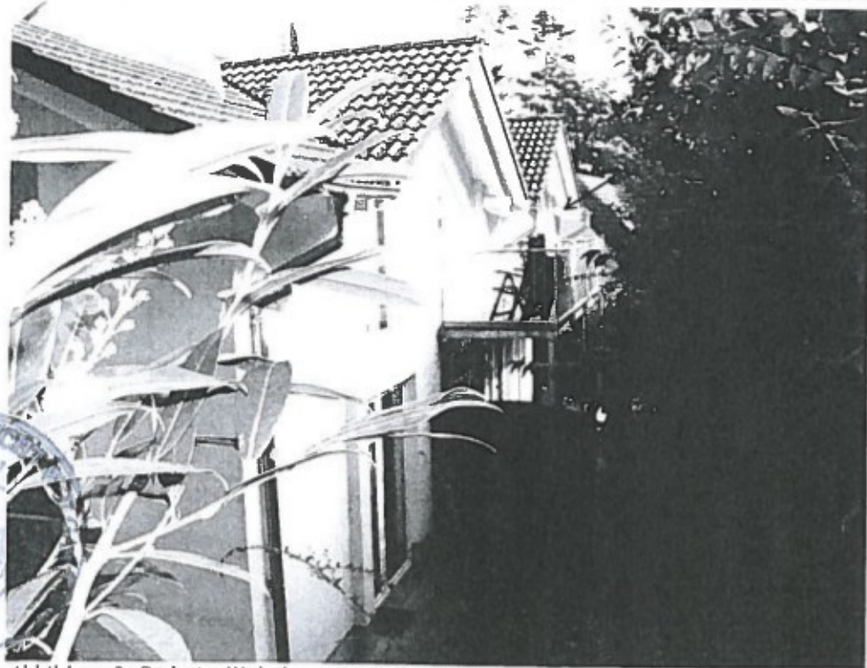
Abbildung 2: Südseite Wohnhaus mit Balkon Wohnung 5
