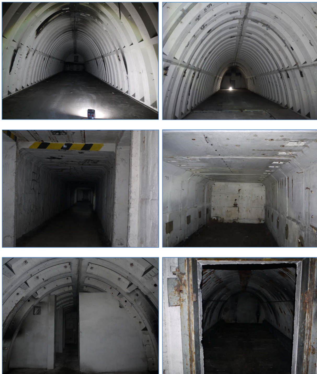
Abb. 4 bis 9 Innenansichten des beräumten Bunkers.
