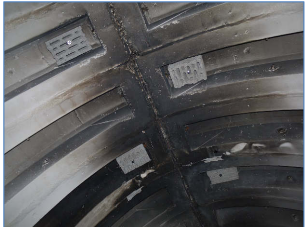
Abb. 11 Anlage von Fledermausversteckplätzen - Montage von Hohlkammersteinen.
