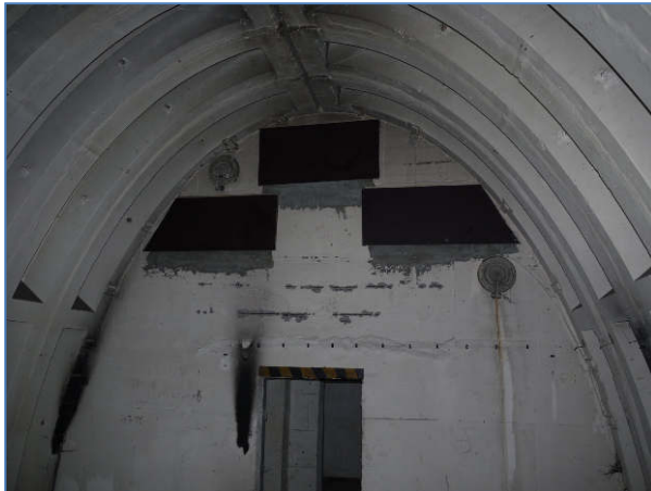
Abb. 10 Anlage von Fledermausversteckplätzen - großflächige Spaltenquartiere aus Schalttafeln.
