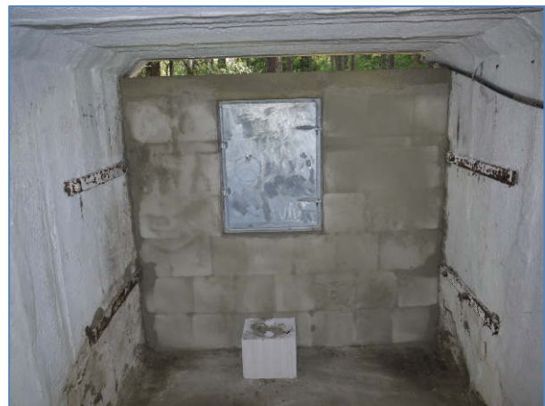
Abb. 3 Innenansicht des vermauerten Eingangsbereiches mit Kontrollluke und Einflugöffnung (KEL Bunker Trassenheide).
