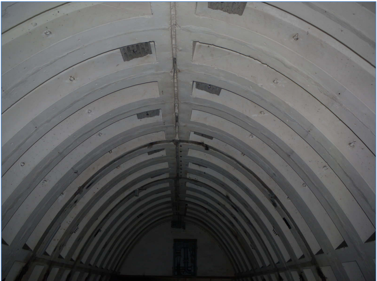
Abb. 12 Anlage von Fledermausversteckplätzen - Montage von Hohlkammersteinen.
