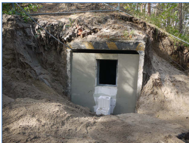
Abb. 2 Außenansicht des vermauerten Eingangsbereiches mit Kontrollluke und Einflugöffnung (KEL Bunker Trassenheide).
