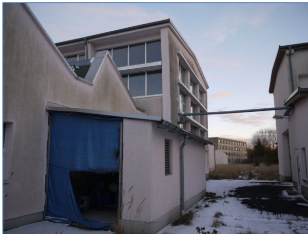
Abb. 21 Anbau mit Quartierspalt im Inneren
