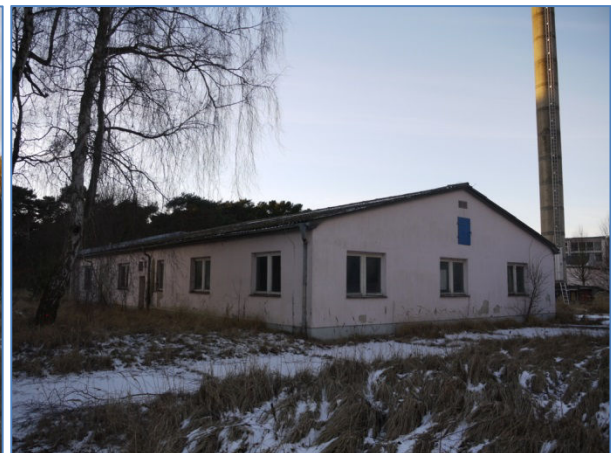
Abb. 12 Betriebsgebäude und Schornstein
