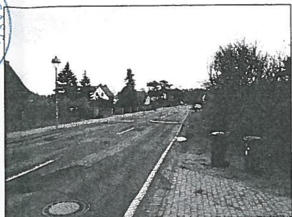
Blick vom Erschließungsweg in die Bahnhofstraße
