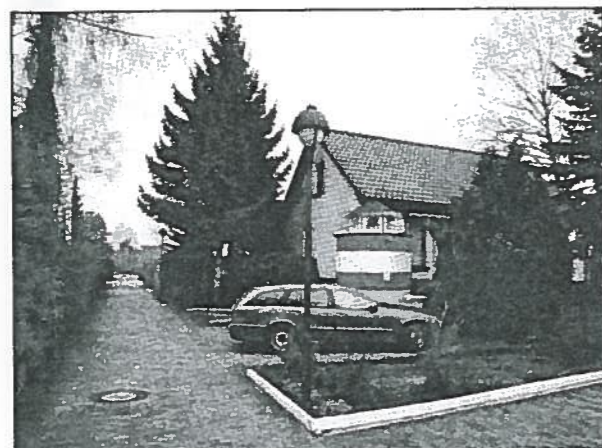
Erschließungsweg mit Bewertungsobjekt rechts im Bild
