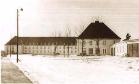
Gebäude W21 von Norden, Quelle: Stüwe 2003, Bild 5(1)
