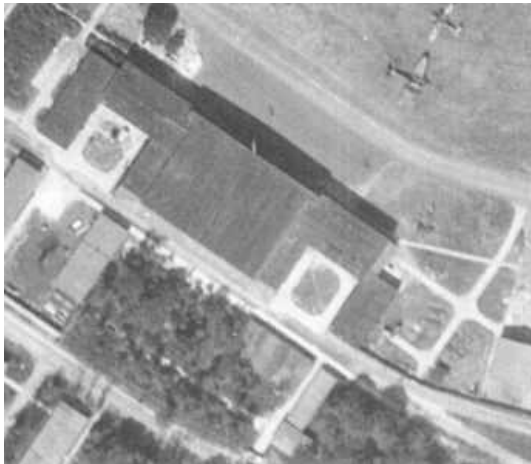
Halle W2 mit angrenzenden Gebäuden und Straßen, 44_042_00_4009_L_1948
