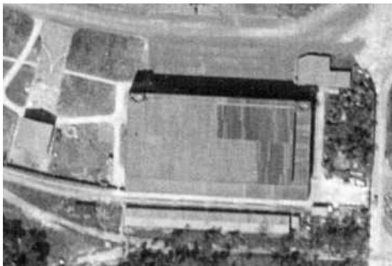
Halle W1 mit betoniertem Arbeitsfeld nach Norden und Gleisanschluss im Süden. 44_042_00_4009_L_1948
