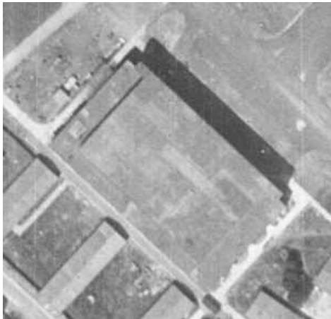
Halle W3 im Luftbild 44_042_00_4009_L_1948
