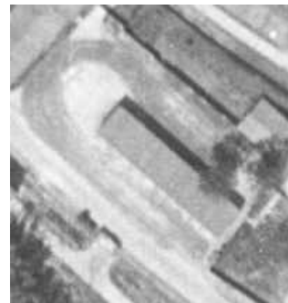
Ansicht der Baracke mit umlaufender Betonfläche in Luftbild 44_042_00_4009_L_1
