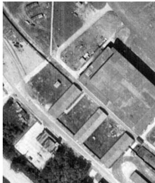
Bereich südlich der Halle W3 (1) mit drei parallelen Baracken. 44_042_00_4009_L_1948
