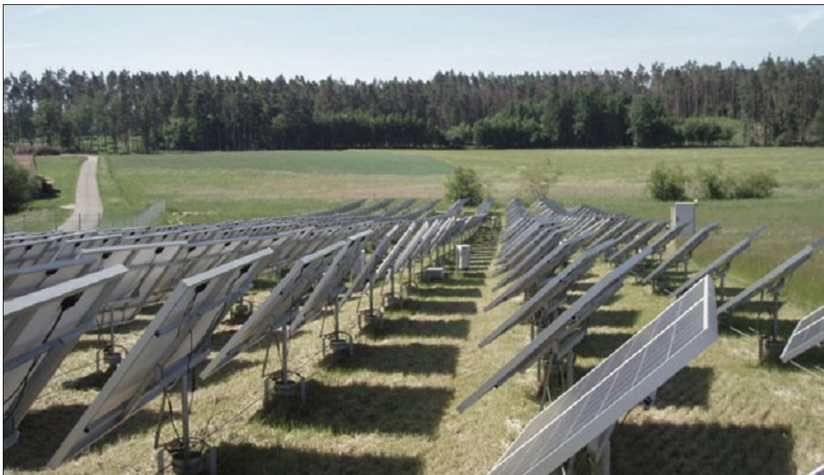
Abbildung 3: Solarfeld mit direkt am Erdboden verankerten Trackern (aus Produktbroschüre von TechnoSunSolar)
