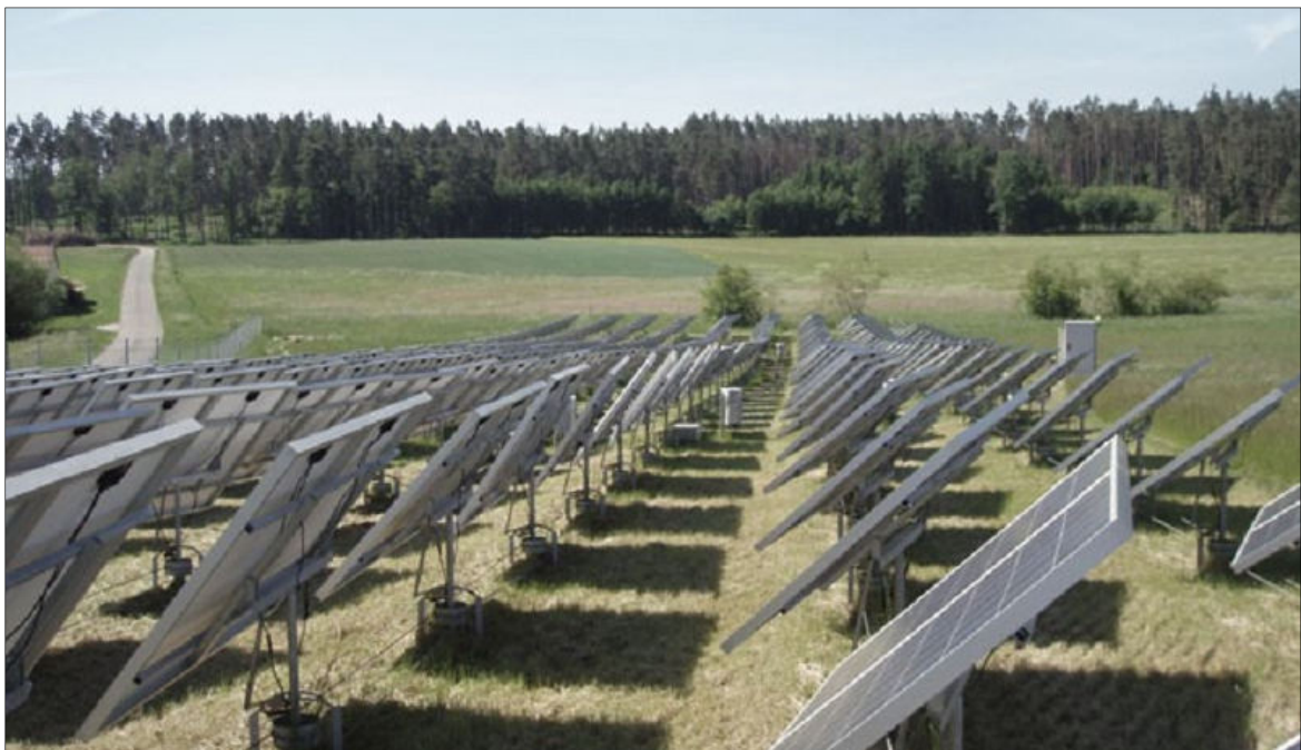
Abbildung 4: Solarfeld mit direkt am Erdboden verankerten Trackern (aus Produktbroschüre von TechnoSunSolar)
