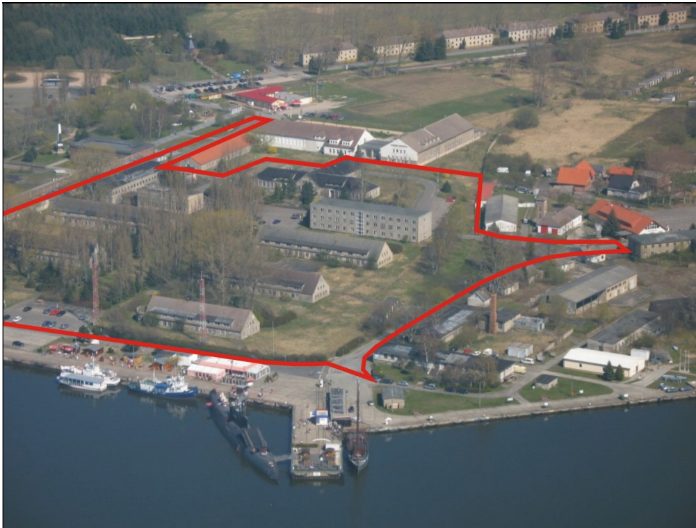
Abbildung 5: Ehem. Marinedienststelle vor Abbruchmaßnahme
