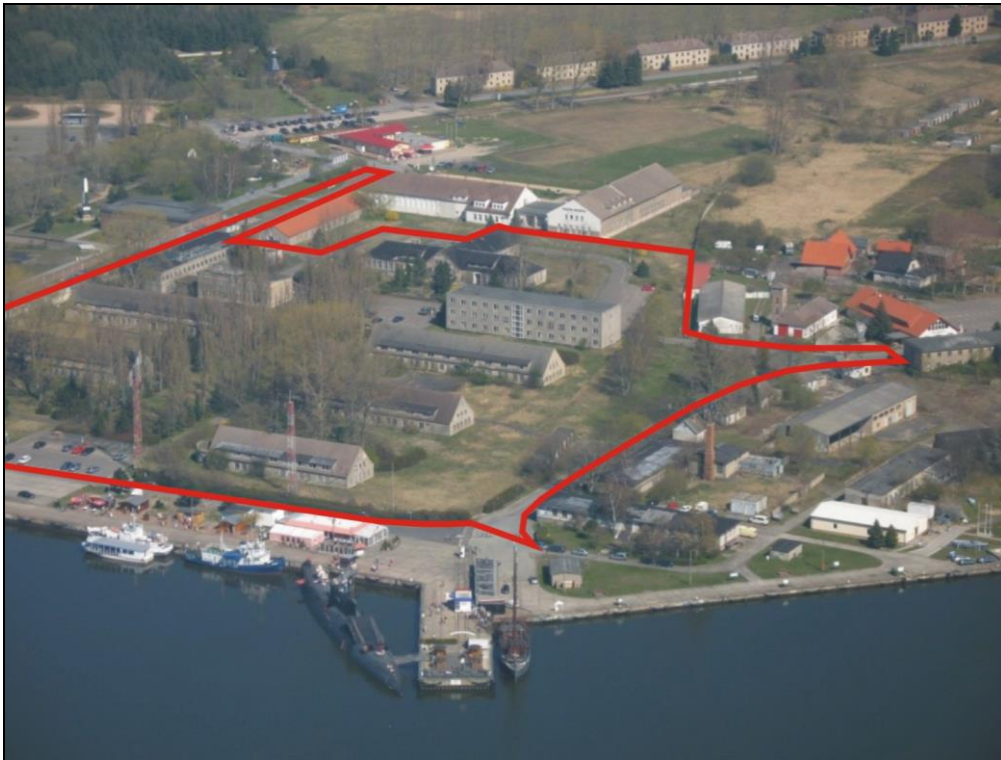
Abbildung 5: Ehem. Marinedienststelle vor Abbruchmaßnahme
