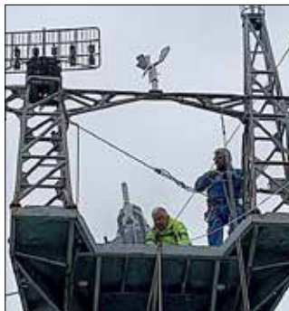
Anbau der FFK-Antenne - Der Windmesser ist am alten Platz
