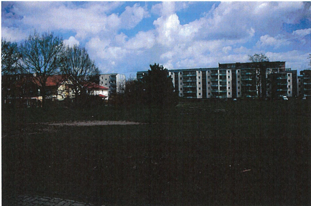
Abb. 2 Blick auf den nördlichen Rand des Grundstücks
