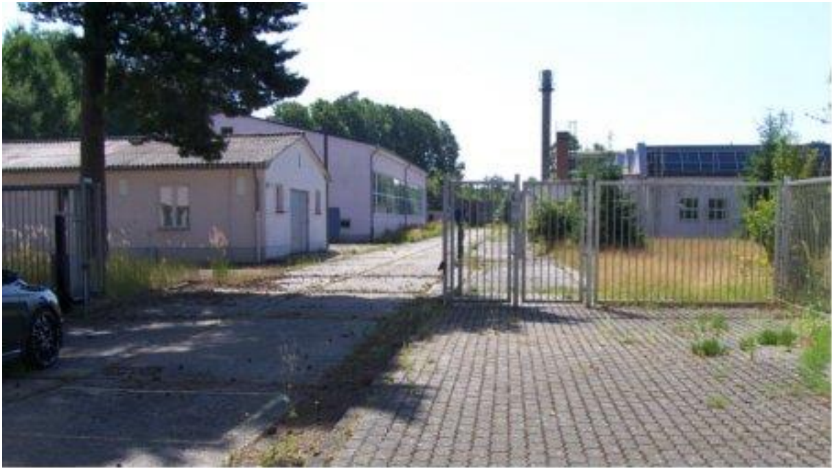
Zugangsbereich zu dem ehemaligen Betriebsgelände der mbt Maschinen- und Metallbau GmbH & Co.KG. Es überwiegen Gebäude und versiegelte Wege- und Lagerflächen.
