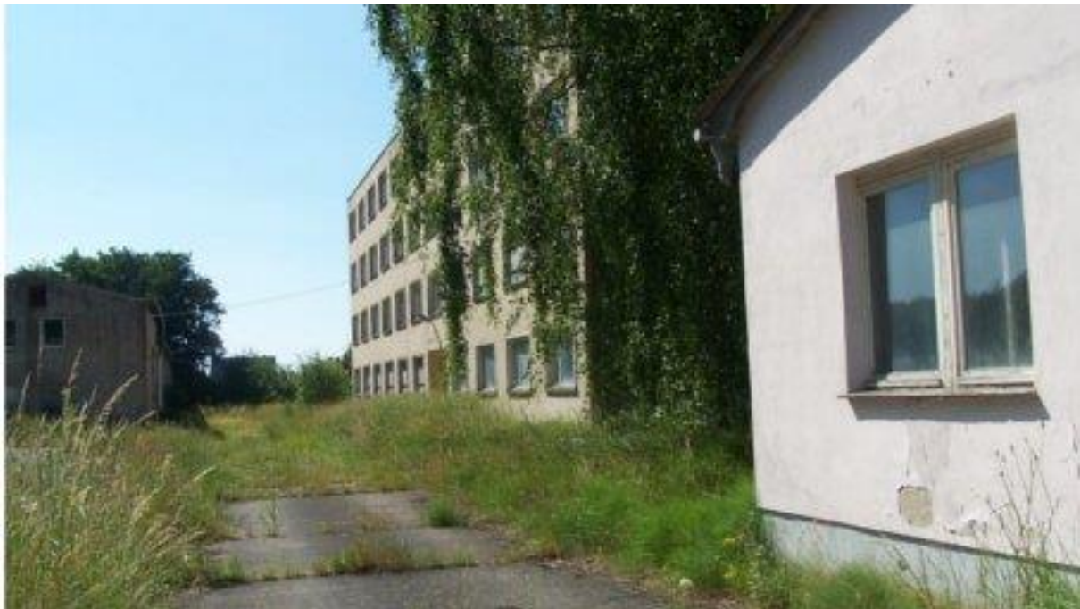
Blick auf den mehrgeschossigen Plattenbau. Die Grünflächen weisen infolge der Auflassung ruderale Vegetationen auf.
