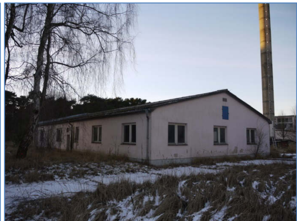
Abb. 12 Betriebsgebäude und Schornstein
