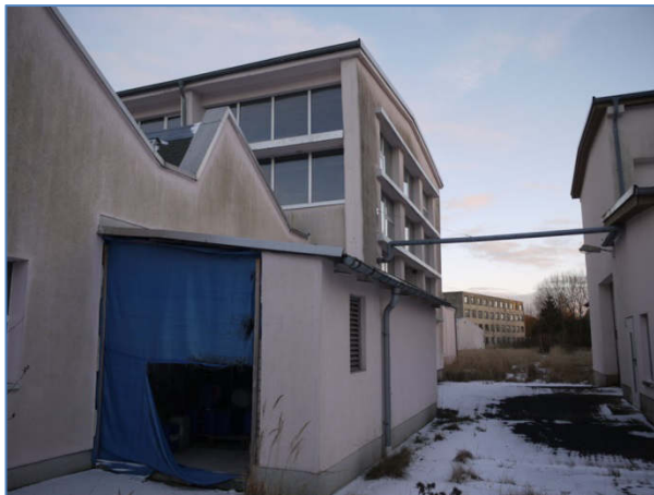
Abb. 21 Anbau mit Quartierspalt im Inneren
