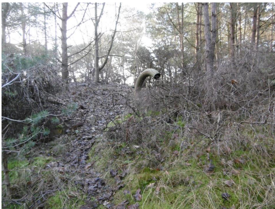
Foto 3: Lüftungsschächte und das höhenmäßig bewegte Gelände lassen die unterirdisch verlaufende Bunkeranlage vermuten.
