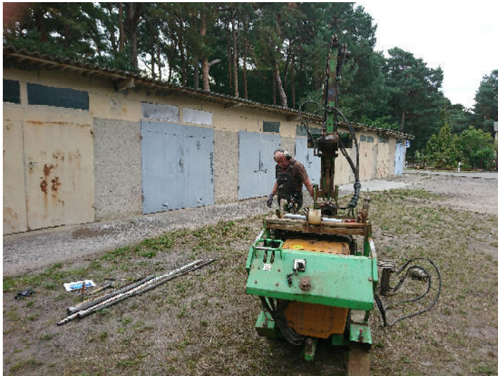
Abbildung 4: Blick auf die Betonfläche vor den Garagen
