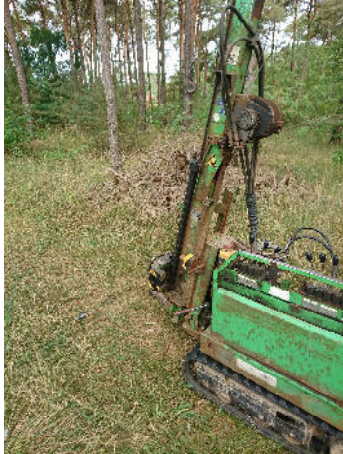
RKB 4 Standort und Bohrung
