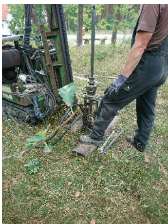
RKB 3 Standort und Bohrung
