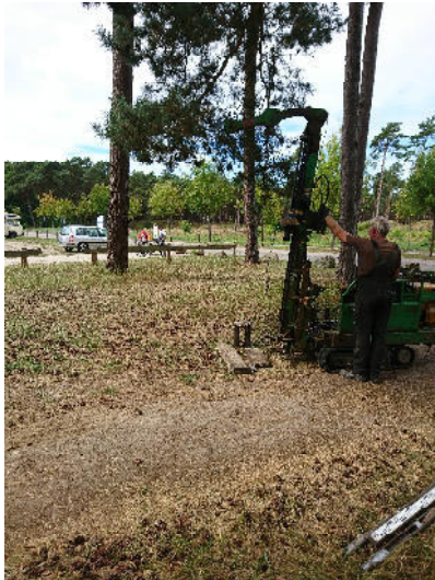
Abbildung 3: Blick auf das Baugrundstück
