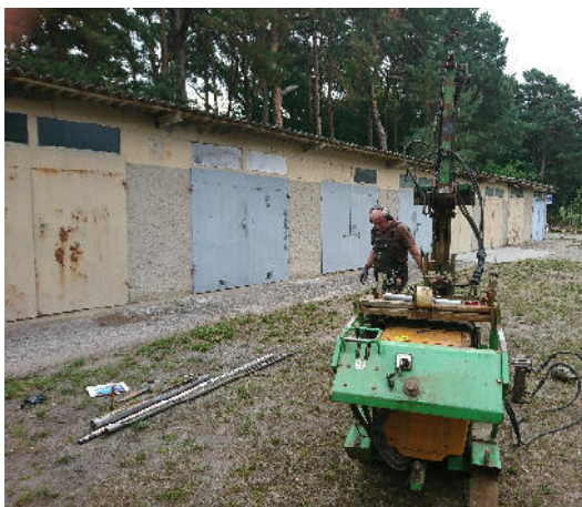
RKB 6 Standort und Bohrung
