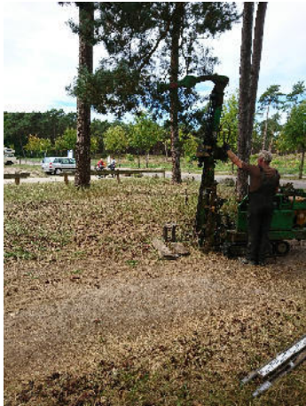
RKB 1 Standort und Bohrung
