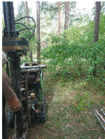
RKB 2 Standort und Bohrung
