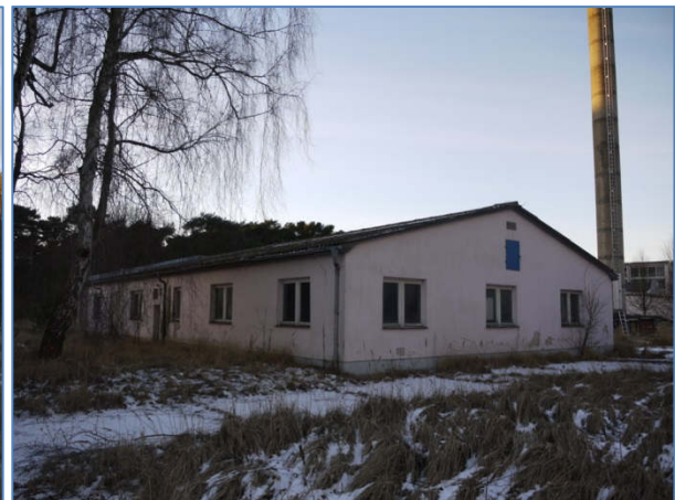
Abb. 12 Betriebsgebäude und Schornstein
