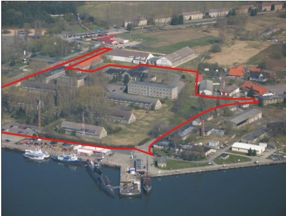
Abbildung 7: Ehemalige Marinedienststelle vor Abbruchmaßnahme
