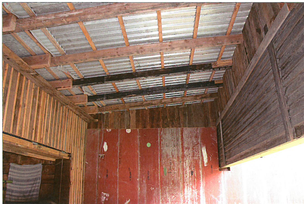
Foto 5: 50 m-GK-Bahnenschießstand: Vorgezogene Überdachung bis zur 1. Hochblende.
