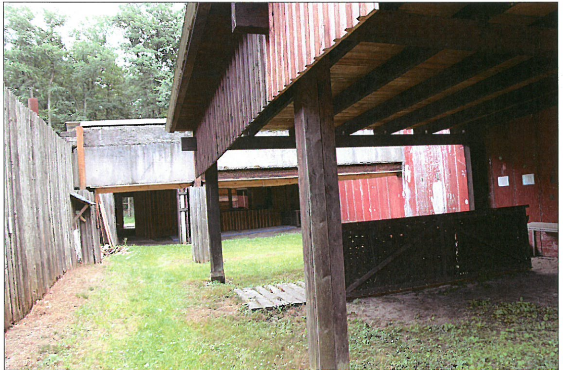
Foto 7: 50 m-GK-Bahnenschießstand: Blick entgegen Schussrichtung auf den Schützenstand außerhalb des Schießhauses bei einem Abstand von 35 m zum Kugelfang für jagdliches Schießen mit Flinte.
