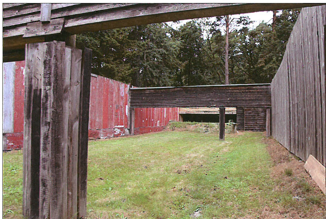
Foto 6: 50 m-GK-Bahnenschießstand: Seitenwände und Hochblenden, Blick in Schussrichtung
