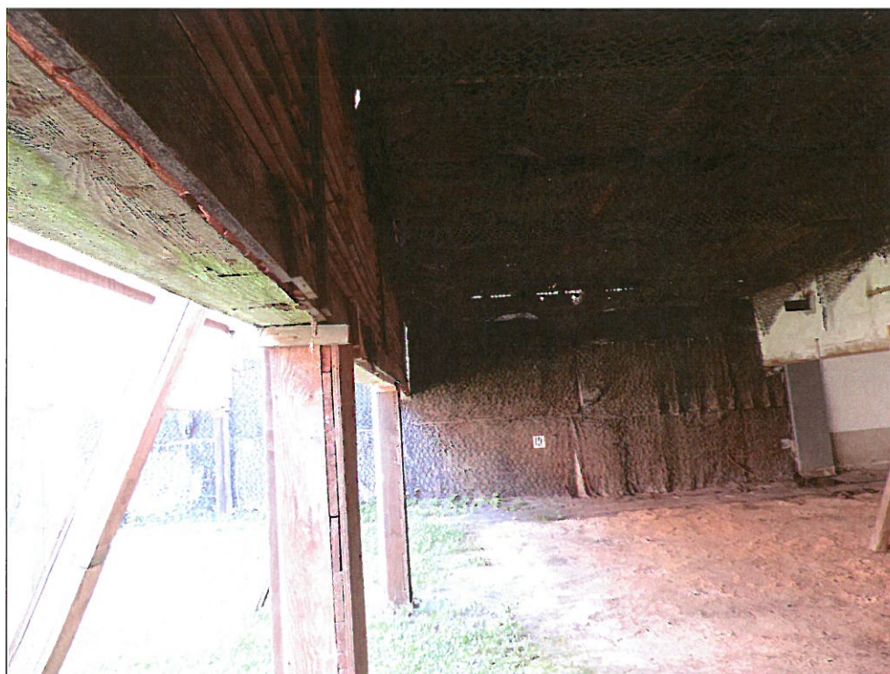
Foto 14: 25 m-KK/GK-Bahnenschießstand: Die Überdachung außerhalb des Schützenhauses ist bis zur 2. Hochblende vorgezogen.
