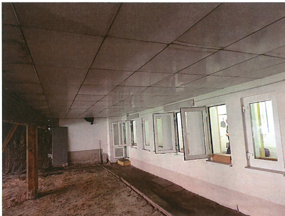
Foto 13: 25 m-KK/GK-Bahnenschießstand: Die Überdachung außerhalb des Schützenhauses ist bis zur 1. Hochblende vorgezogen.
