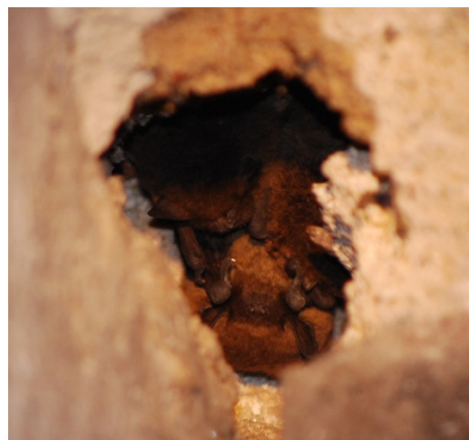
Abbildung 7: Winterquartier von Pipistrellus spec. in Deckenloch in Mittelstufe. A. Petzold, 19.02.2012
