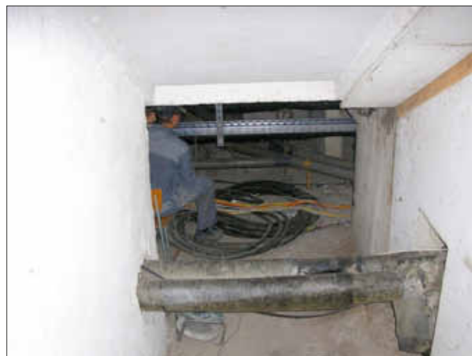
Kriechgang unter der Schule mit neuen Leitungsbahnen.
