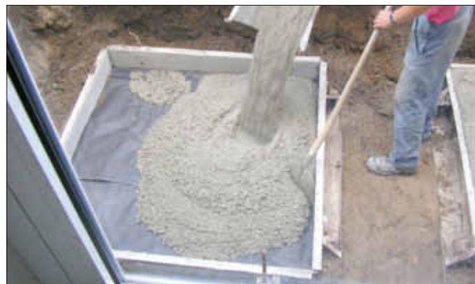
Der erste Beton fließt.
