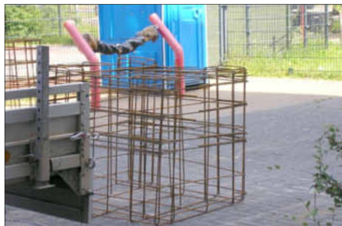
Stahlbewehrung für die Fundamente.
